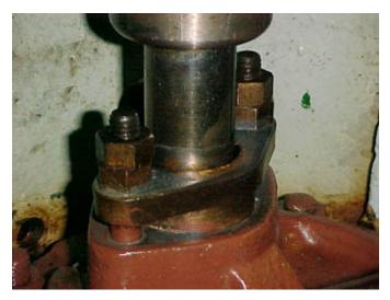
PUMP PACKING BOX WITH ADJUSTMENT LOCK NUTS
