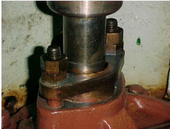
**PUMP PACKING BOX WITH ADJUSTMENT LOCK NUTS**
