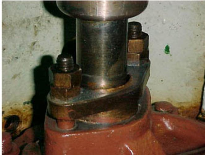
**PUMP PACKING BOX WITH ADJUSTMENT LOCK NUTS**
