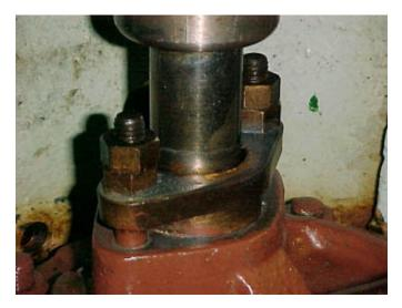
PUMP PACKING BOX WITH ADJUSTMENT LOCK NUTS
